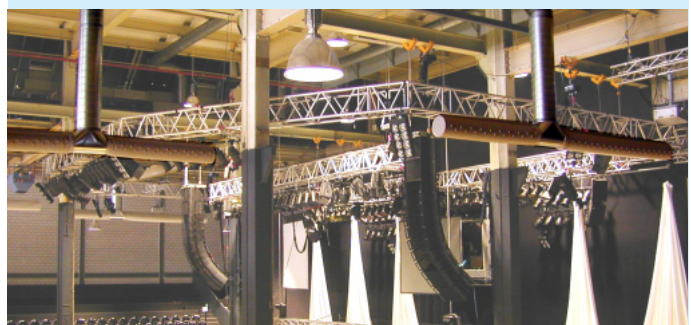
Textilschlauch mit integrierten Düsen (DireJet-System) für zielgerichteten Einblas mit grosser Wurfweite für Kühl- und Heizbetrieb.
