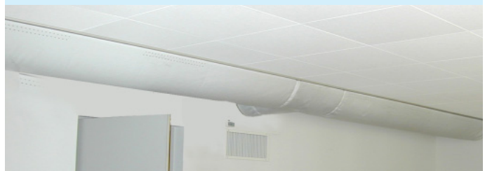
Textilschlauch halbrund mit Laserlochung für teilweisen Einblas gegen den Raum.
