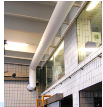
KE-Textilschlauch als Transportschlauch in dichter Ausführung.
