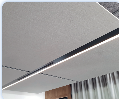
Les applications typiques sont les immeubles de bureaux, les écoles, les bâtiments publics et les aéroports, où 50 à 75% de la surface du plafond est recouverte de panneaux de chauffage et de refroidissement
