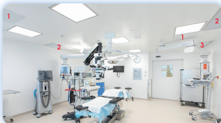
1 Diffuseurs à filtre à particules, au-dessus de la zone de travail 2 Batterie de froid, 3 Filter-Fan-Unit dans la zone marginale
