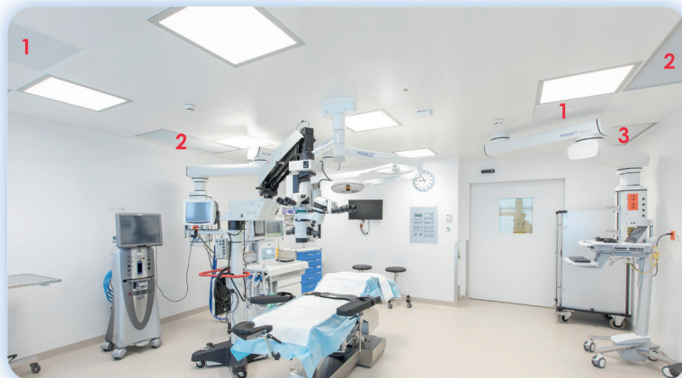
1 Schwebstoff-Filter-Luftdurchlässe über der Arbeitszone 2 Kühler, 3 Filter-Fan-Unit in der Randzone
