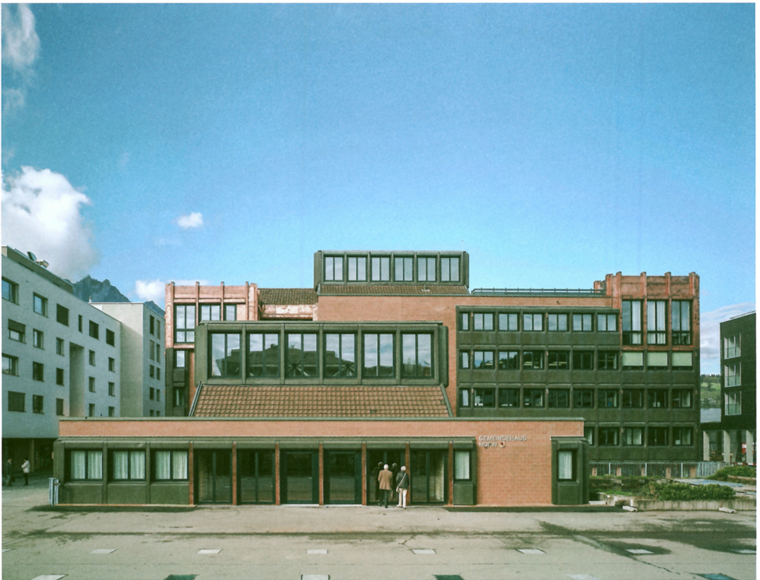
Mit den Erhöhungen rechts und links behauptet sich das 35-jährige Haus gegenüber den aufgestockten oder neugebauten Nachbargebäuden.
