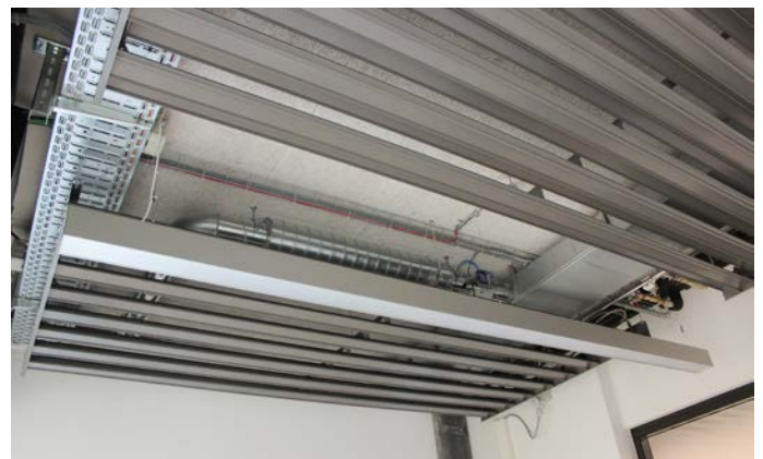
Bild 4: Das statische Kühl- und Heizdeckensystem SKS-4/3 duo.
