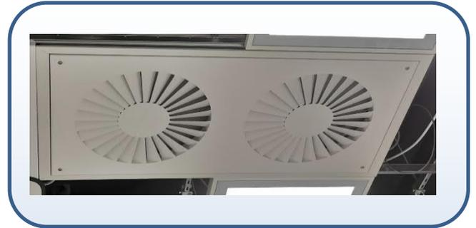
Diffuseur radial en option pour une ventilation mixte turbulente optimale avec des exigences de tirage très élevées dans la pièce.
