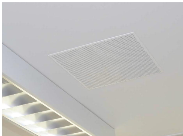
Figure 7: Opticlean intégré dans un plafond placoplâtre
