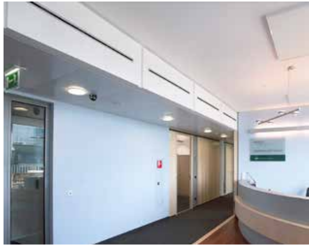
Figure 3: Diffuseur mural à fentes dans la zone d'accueil d'un immeuble administratif
