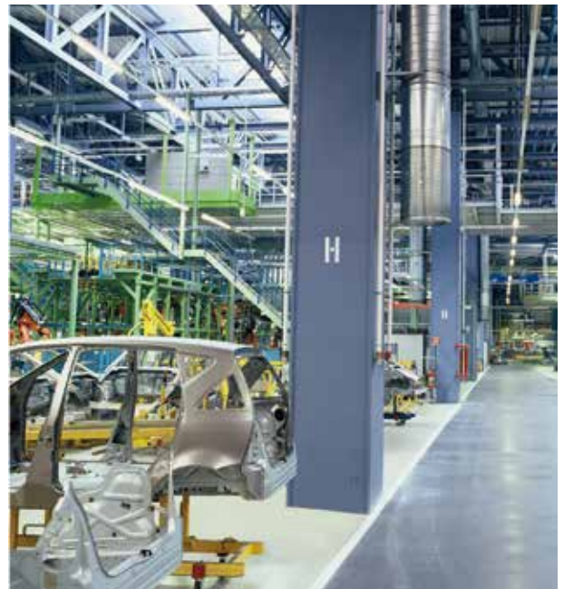
Figure 13: Diffuseurs de refoulement cylindriques dans des ateliers de construction automobile
