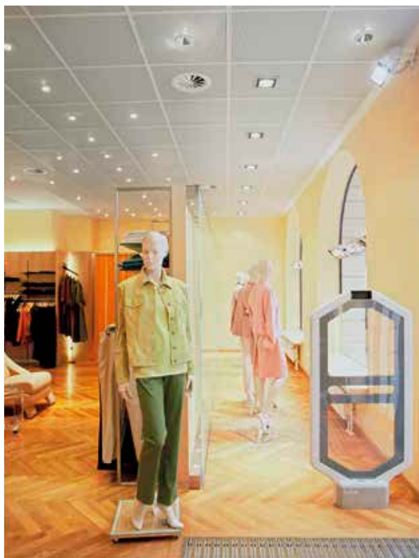
Diffuseur radial avec face apparente ronde dans une boutique
