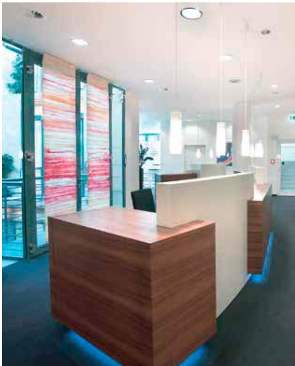
Diffuseurs radiaux à face apparente ronde dans un hall d'accueil
