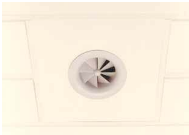
Diffuseur à pulsion giratoire encastré dans un faux-plafond fermé
