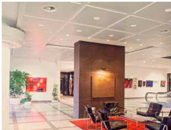
Diffuseurs à pulsion giratoire installés dans le hall d'accueil de la société DEA Mineralöl AG, Hambourg
