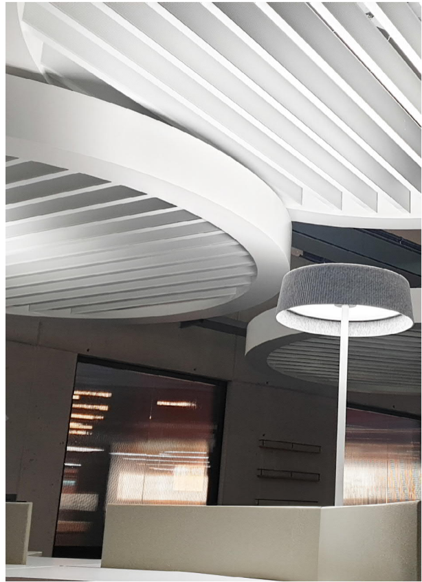
Image 1: Plafonds rafraîchissants à lamelles en version spéciale
