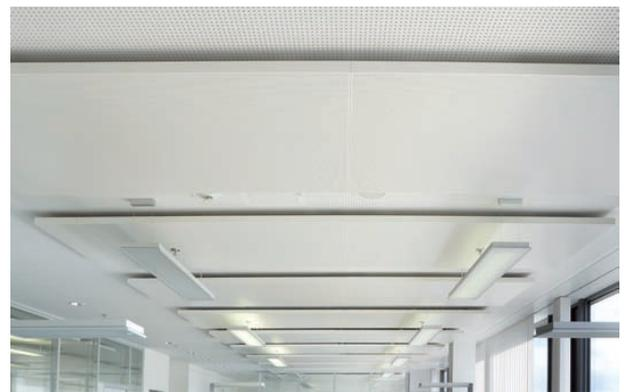
Image 6: Voile multifonctionnelle glissée sur les traverses
