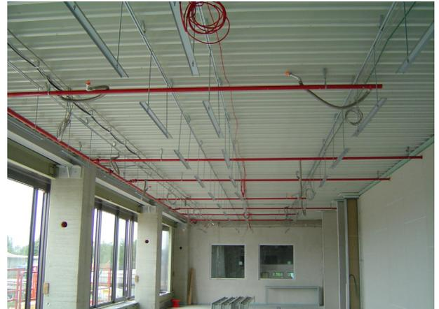
Image 5: Pour le montage, les traverses suspendues sont suspendues au plafond à l'aide de tiges filetées et alignées
