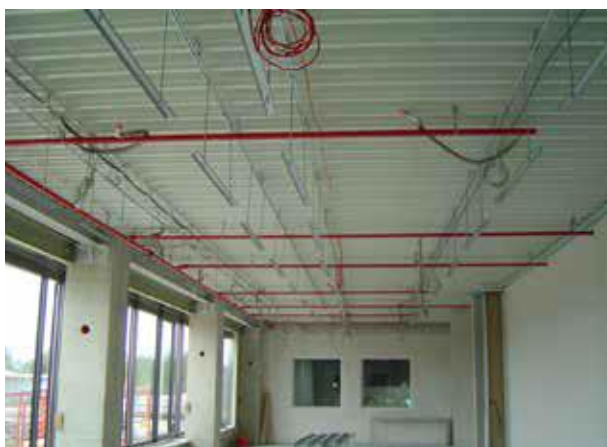
Figure 6: Pour le montage, des traverses d'accrochage sont suspendues au plafond et alignées au moyen de tiges filetées.
