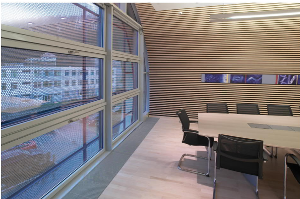
Figure 1: Diffuseur de sol à déplacement d'air rectangulaire devant une façade
