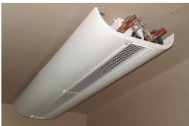
Bild 14: Aktiver Deckenkühlkonvektor mit Abdeckung der Installationen durch seitliche „Wings“
