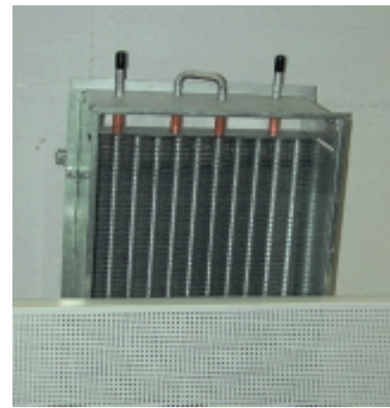
Bild 3: Verdeckte Installation des Deckenkühlkonvektors oberhalb einer luftdurchlässigen Zwischendecke
