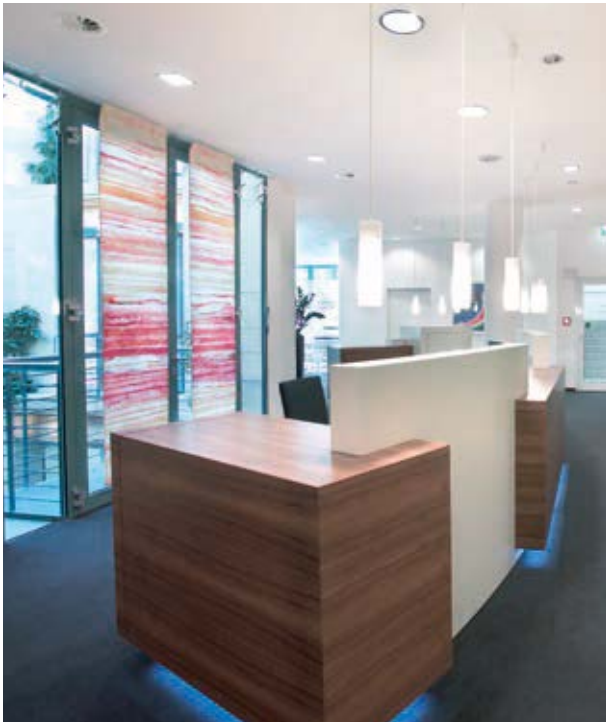
Radialauslass mit runder Sichtfläche in einem Empfangsbereich
