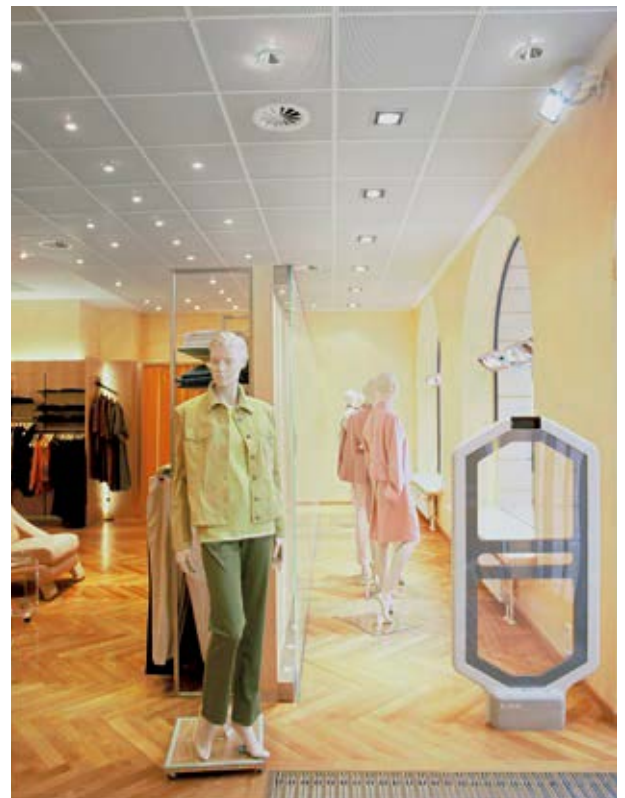
Radialauslass mit runder Sichtfläche in einer Boutique
